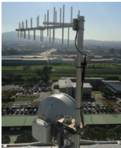
Antena de banda blanca de TV transmitiendo banda ancha para las escuelas locales en Ciudad del Cabo, como parte de la prueba sudafricana del espacio en blanco de la banda de TV (TVWS, por su sigla en inglés).
