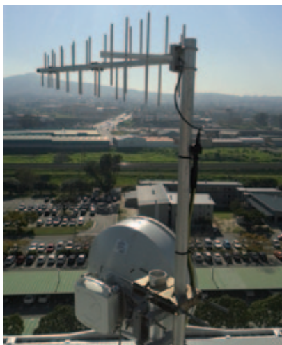
Une antenne captant les espaces blancs de télévision apporte le large bande à des écoles locales de la ville du Cap dans le cadre des essais TVWS d'Afrique du Sud.
